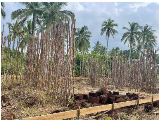
**Gambar 2** Pemasangan Cerucuk Bakau untuk perkuatan struktur pondasi bangunan
